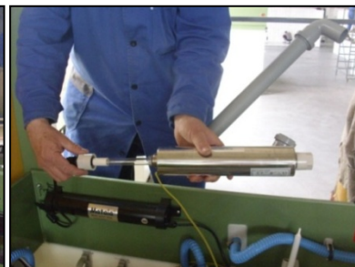
Fig. 8: Kabel med UV-lampe dras ut
