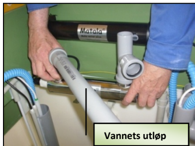
Fig. 6: Frigjøring av vannets utløp
